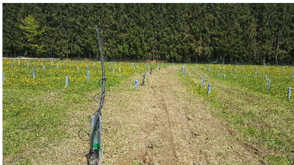
Abbildung 2: Verfüllter Kabelgraben
