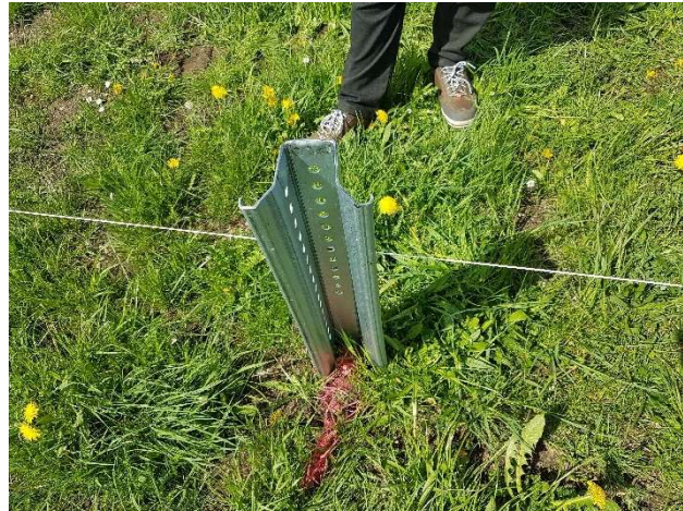
Abbildung 4: Rammfundament
