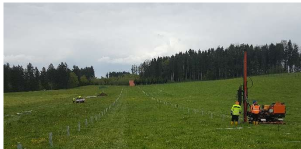
Abbildung 1: Hydraulikramme auf Ketten
